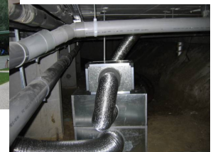
Rafrâichissement d'une maison de retraite par puits climatique
